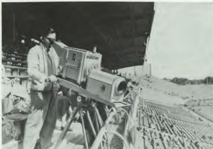
Fig. 10 — Câmara fotográfica orticon com objectiva Watson Zoom
