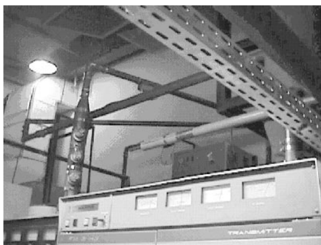
Figura 2.20: Foto de parte de um transmissor FM mostrando trechos de cabos coaxiais rígidos.
